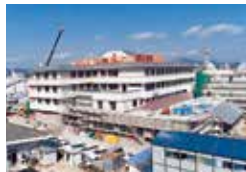
建設中の倉敷平成病院 昭和62年
