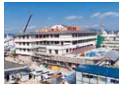
建設中の倉敷平成病院 昭和62年
